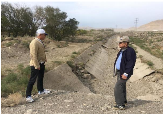
Şəkil 5,6,7,8. Sədarək və Qərbi Şərur maili düzənliklərində keyfiyyətsiz tikilmiş kanallar və su axan kanalların uzun müddət təmizlənməmiş sahələri
