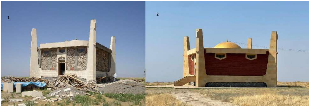
Şəkil 2. Asnı piri. 1-Bərpa olunarkən görünüşü; 2-Bərpadan sonrakı görünüşü (Məhəmməd Bayramov)
